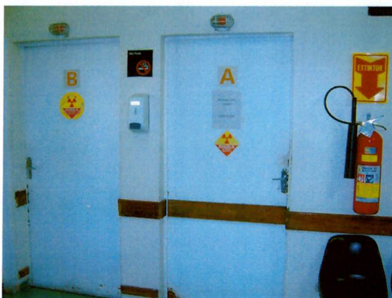
Foto 4 – Visualização das Portas das salas de Raio X, observa-se a sinalização de radiação nas portas bem como a indicação de raios X com dispositivo luminoso acima das portas.
