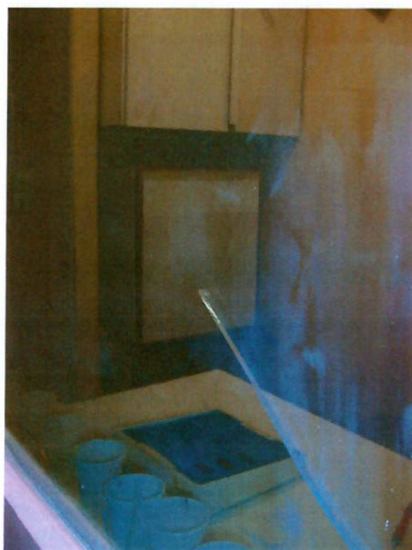
Foto 6 – Visualização do visor da sala de comando com o vidro plumbífero trincado.
